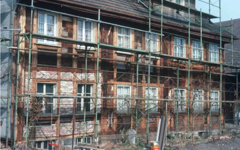
Bohlenständerbau und Fachwerkanbau – Südostseite 1994 (GAR)
