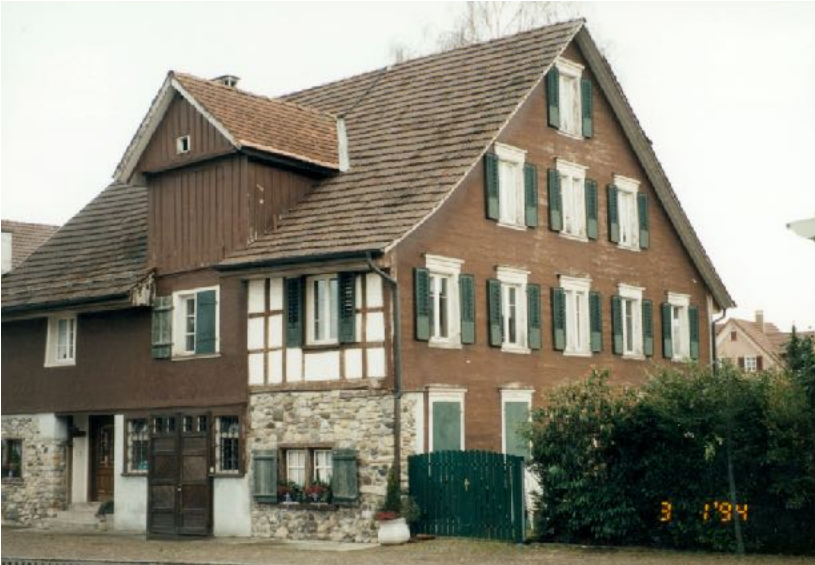
Das Haus am Kreuzweg vor dem Umbau des Aufzugs – 1994 (Gar)
