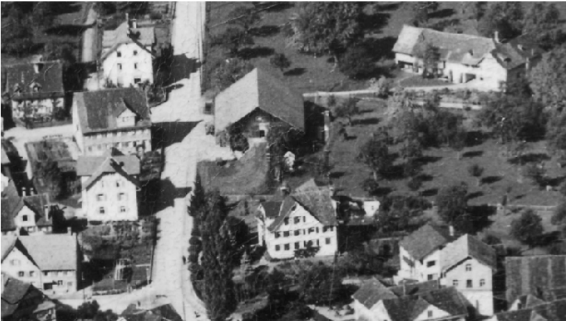
Das Bauerngut am Kreuzweg mit den östlichen Nachbarhäusern – Martin Egger (erbaut 1935) und »Frohheim« (1887) – Flugaufnahme wohl 1952
