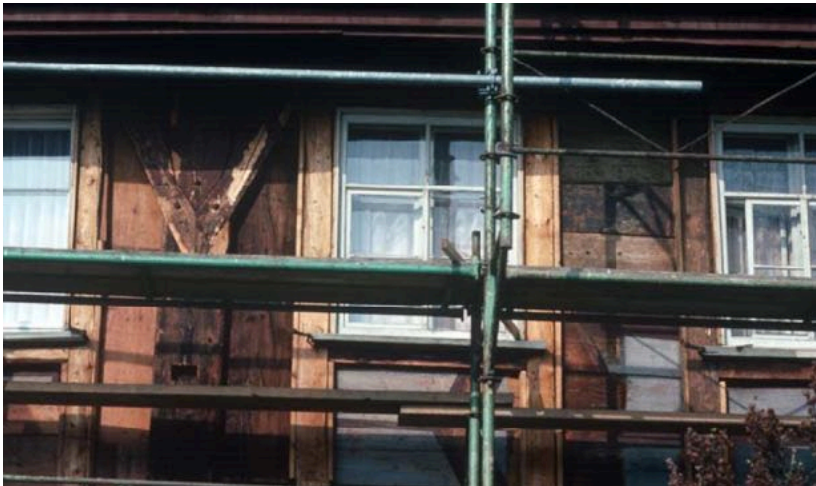
Bohlenständerbau Detail – bei Renovation 1994 (GAR)
