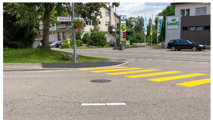
Die Fotos zeigen die Trottoirabsenkungen an der Post- und Kirchstrasse.
