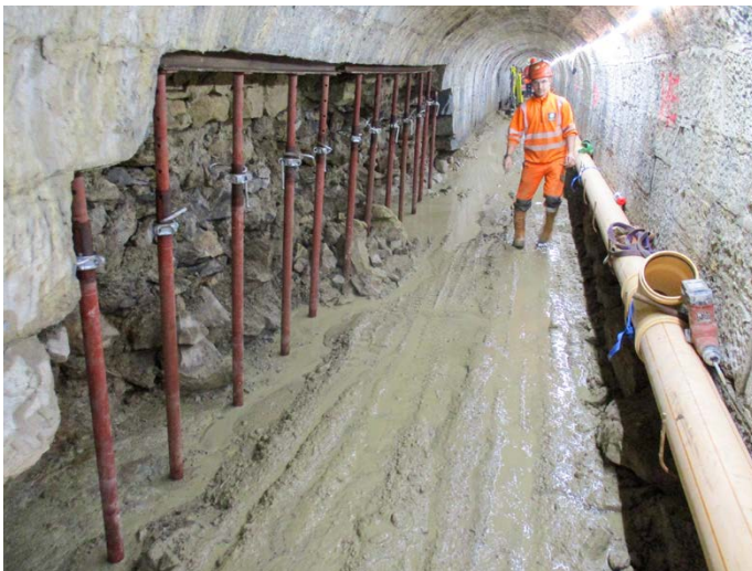
Das Foto zeigt die Sicherung der Stelle mit Stahlrohrstützen.
