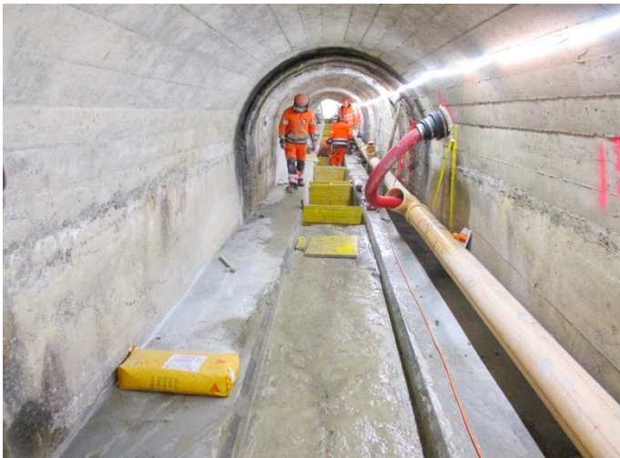
Das Foto zeigt die betonierten Bankette.
